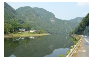
主要地方道新見川上線の沿道
