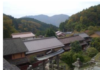
山々に囲まれた吹屋の町並み
