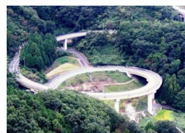
国道 484 号愛宕ループ橋
