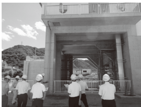
落合雨水ポンプ場
