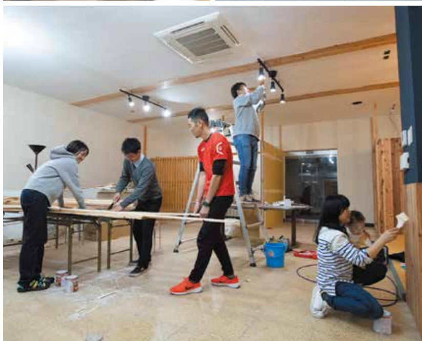
(上)「高梁市は、移住者を歓迎し、みんなで子どもを育てようとしてくれるまち」と横山夫妻 (下)市内中心部の商店街にも、かつて商業施設『エスカ』として親しまれた空き店舗を借り、高梁城南高校の生徒らが授業の一環で改修作業を行うなど、関わり合いの輪が広がっている
