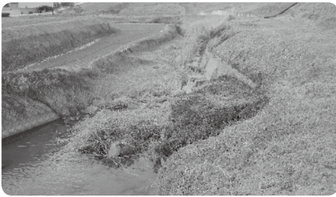
土砂の堆積した河川(有漢町内)
