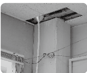
老朽化の著しい市庁舎
