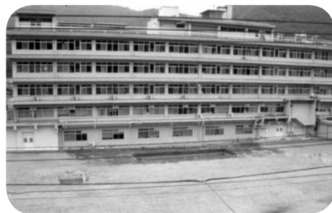
解体された成羽病院の外来部分
