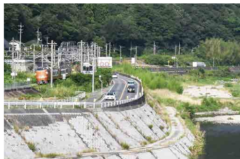
陰陽を結ぶ伯備線と国道180号 （玉川橋から望む）
