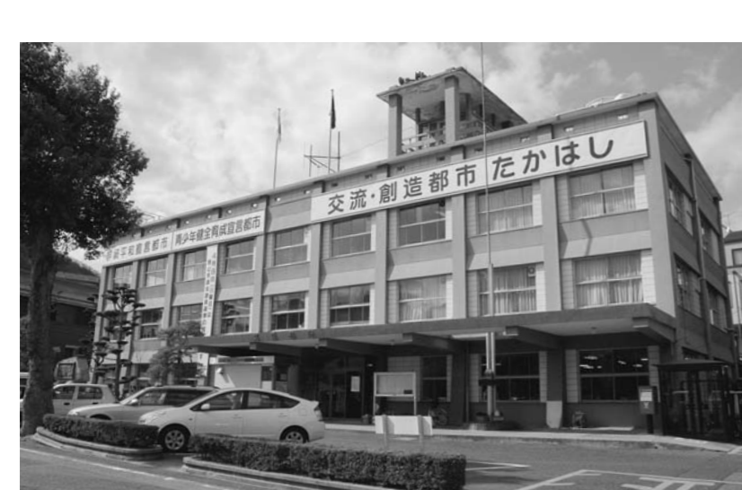
現在の高梁市役所本庁舎
