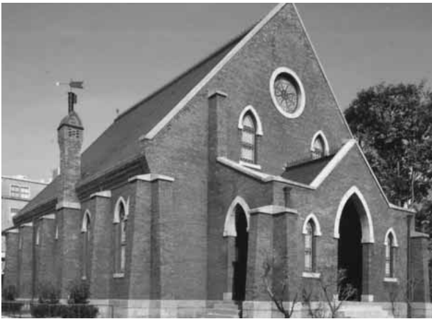
幸助が学んだ同志社大学校舎
