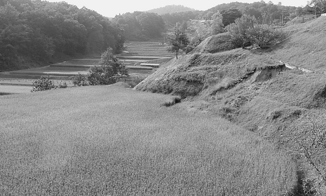
農地への崩土現場（巨瀬町内）
