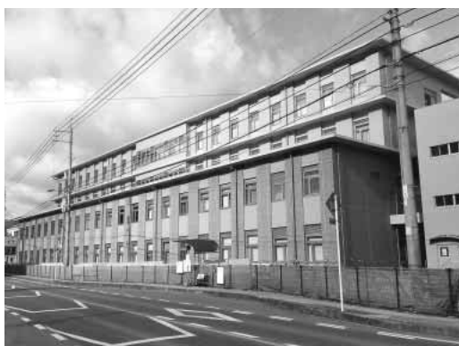
南東側から見た成羽病院外観
