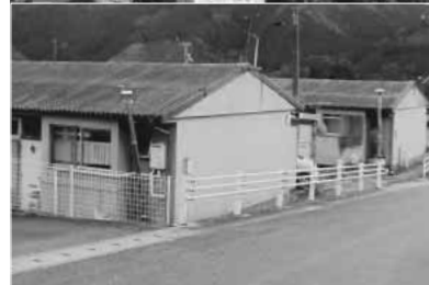
老朽化した市営天神ヶ丘住宅
