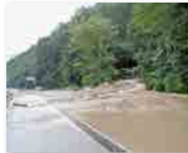
通行不能となった国道313号線 9月2日午後3時ごろ(成羽町・川上町境)
