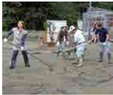
▲約100人の関係者が参加して泥を取り除いた(9月8日)
