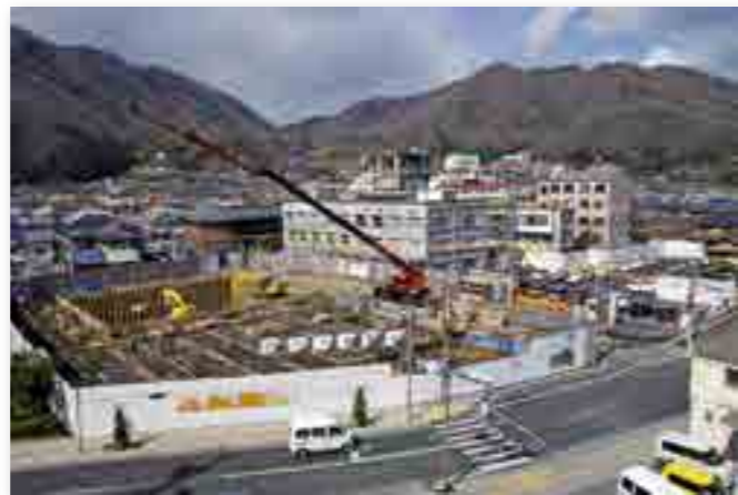
▲ 工事中の様子 (平成26年3月6日撮影)
