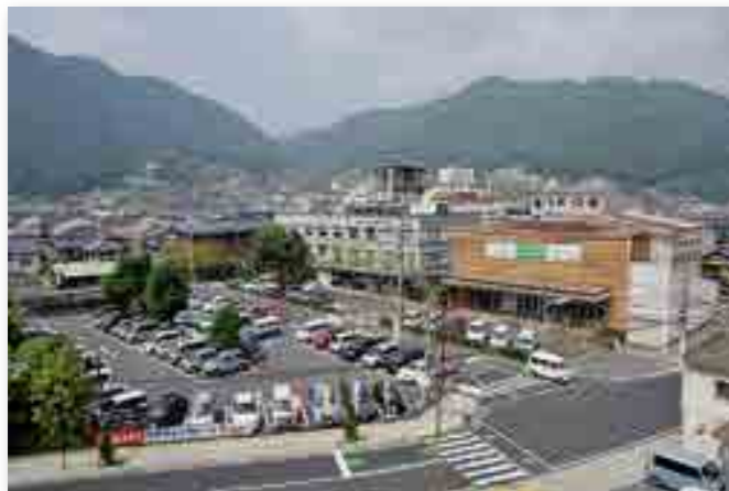
▲ 工事前の様子 (平成25年10月1日撮影)
