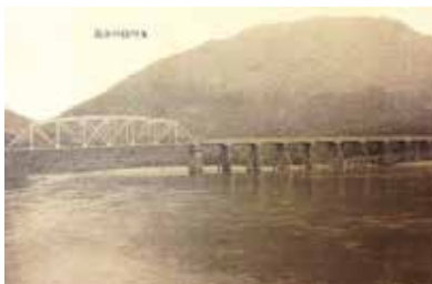
昭和4年当時の玉川橋
