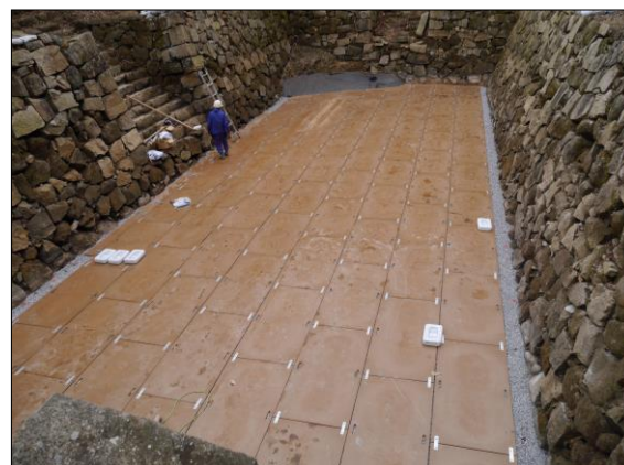
大池内部 プラスチック製板敷設状況(竣工)
