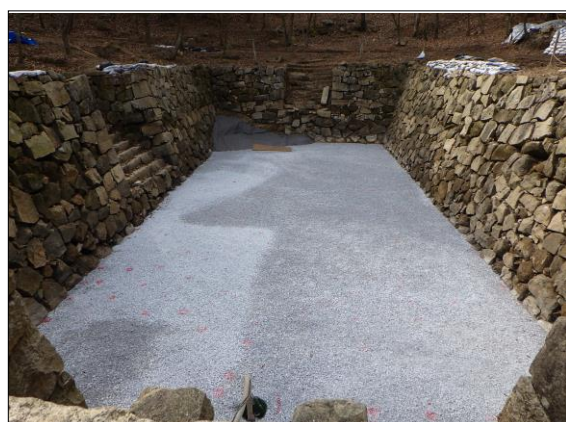
大池内部 石灰岩砂利敷き詰め状況
