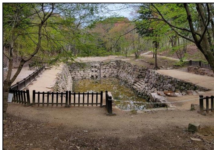
進入防止柵の設置状況
