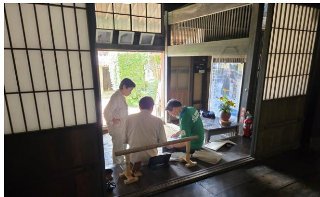
建物調査の様子
