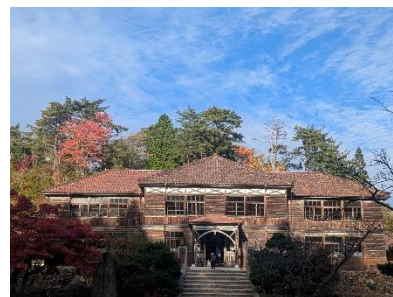
旧吹屋小学校校舎
