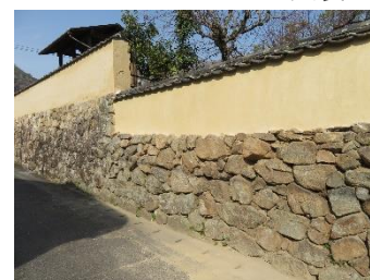
補助金を使った修理(土塀)
