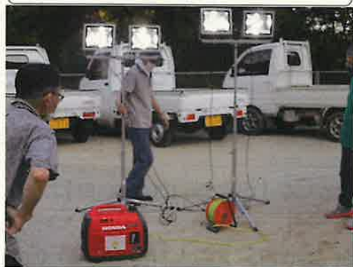
（発電機、投光器×2）
