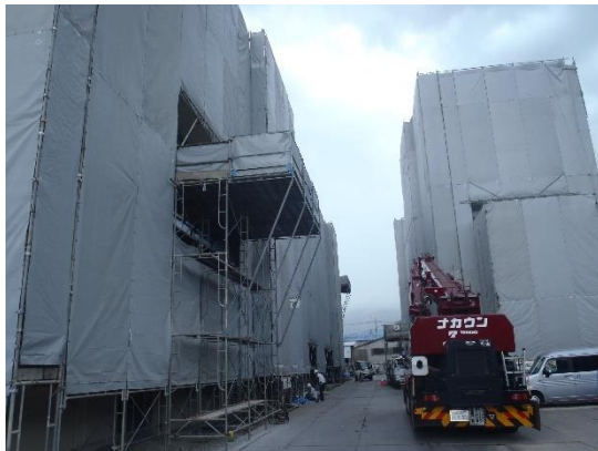
外部 庁舎棟 訓練棟南面 現況
