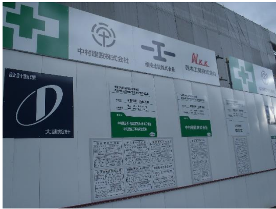
揭示板 建設業許可標識、労災保険関係成立票
