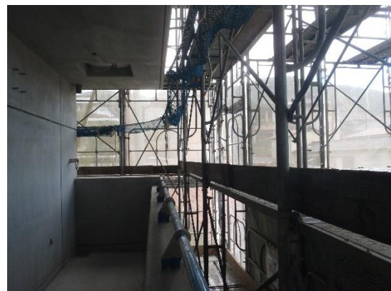
訓練棟 2階バルコニー 現況
