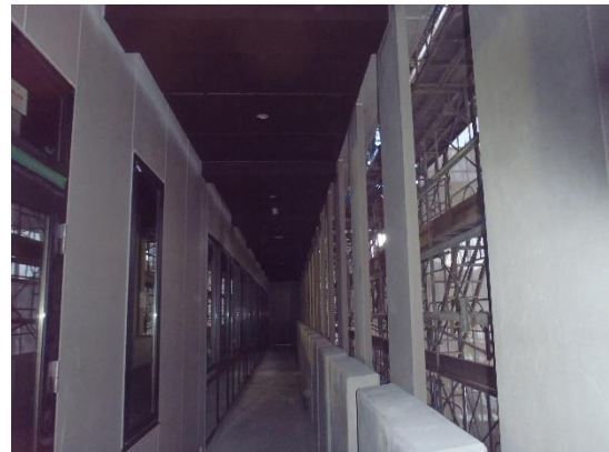
庁舎棟 2階西バルコニー 現況
